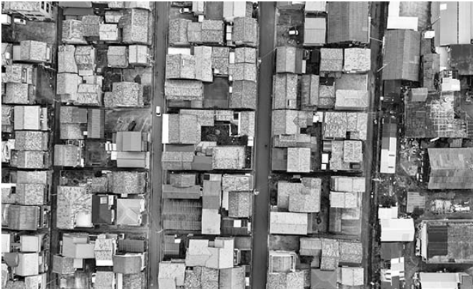
図7 ドローンによる空撮記録(2)
