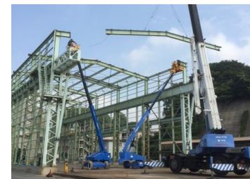
写真2 部材リユース
