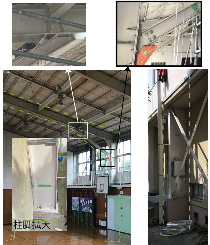
図5 計測対象の詳細写真
