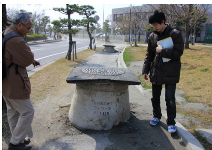
被害調査 (液状化)
