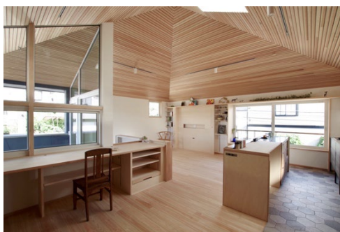
図1：港北E邸（横浜市）在宅ワークの夫婦と2匹の大型犬が住むための住宅。リビングスペースの音環境に配慮して天井の形状と吸音の方法をデザインしている。
