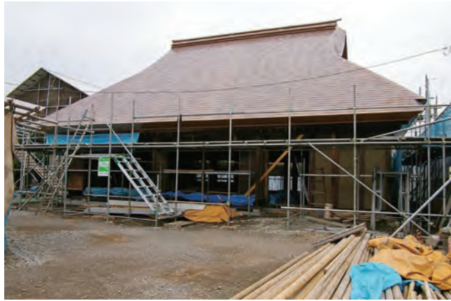
【図 8】小倉家住宅復原工事
