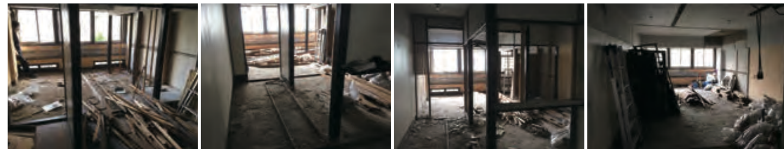
解体が終了しスケルトンが残る
