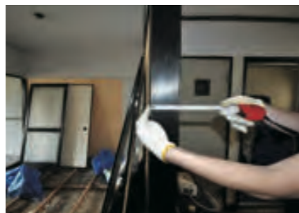
図面作成のため各部の寸法を記録
