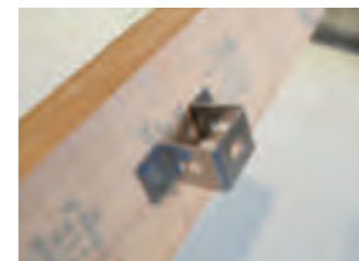
廃材の表面に金具を取付ける
