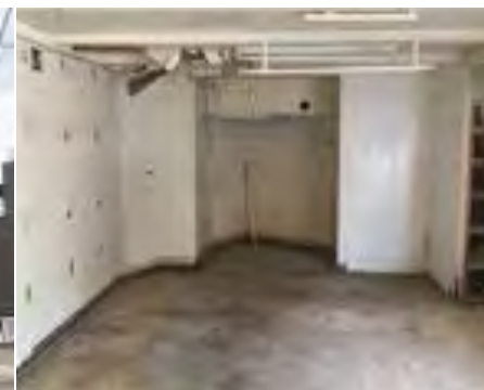
改修前 1階内部
