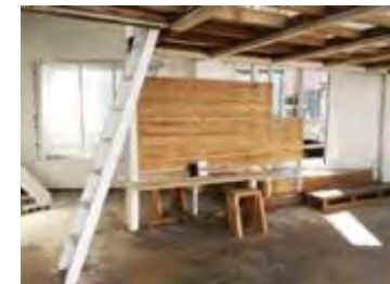
システムウォールを見る
