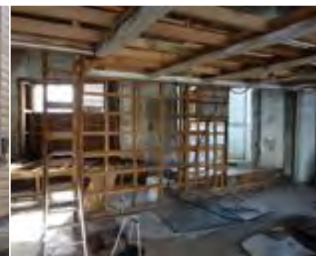
1階内部壁面撤去後
