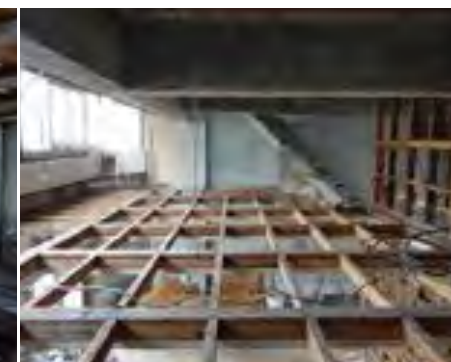
中2階床板撤去後
