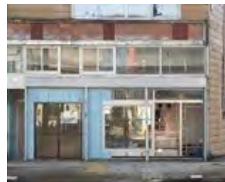
北側壁面撤去後
