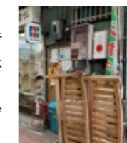
誰でも押せる火災報知器
