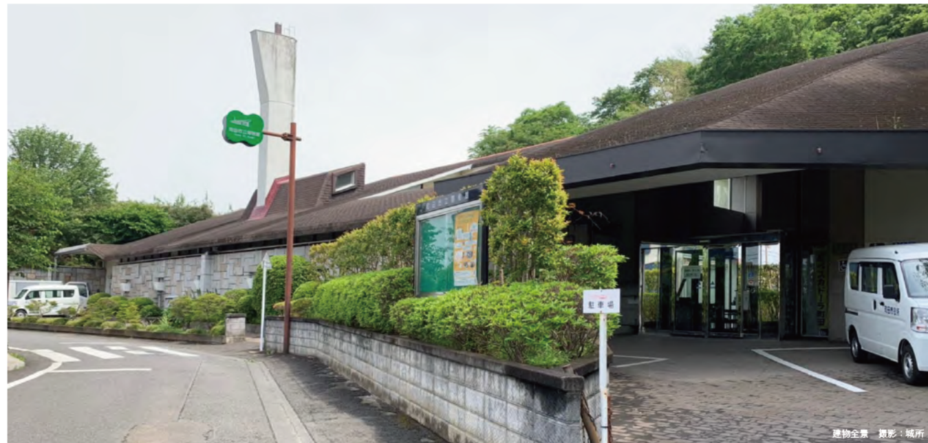
建物全景 撮影：城所
