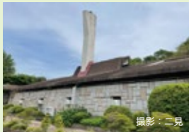
煙突と大屋根 大屋根が水平方向を、煙突が垂直方向を強調している
