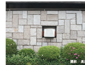
外壁 花崗岩乱積層張りによる表現
