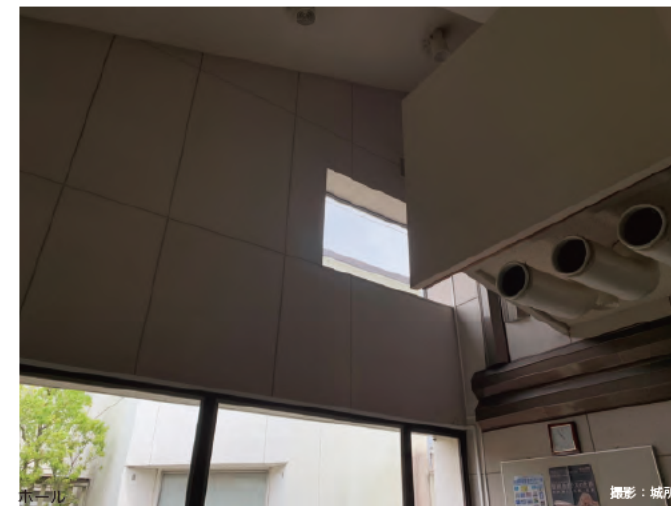
2層分の吹き抜けにより開放的な空間。中庭に面する窓から採光を確保している。
