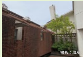
ホールから池を介して事務室を見る 池側に窓が開いている
