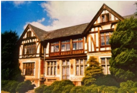
図1 室谷家住宅 6) (平成19年解体) 神戸市、昭和8年竣工ウィリアム・ヴォーリズによる設計。
