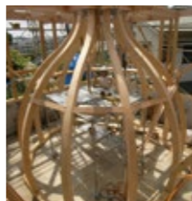
写真⑤ TUBO-SUBAKO 工事風景
