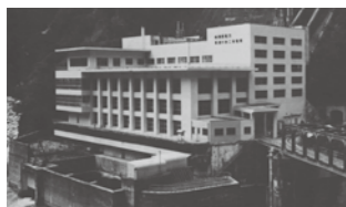
黒部川第二発電所（1936年）
