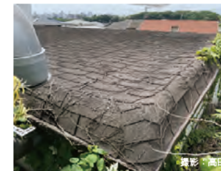
屋根 端が曲線を描いている
