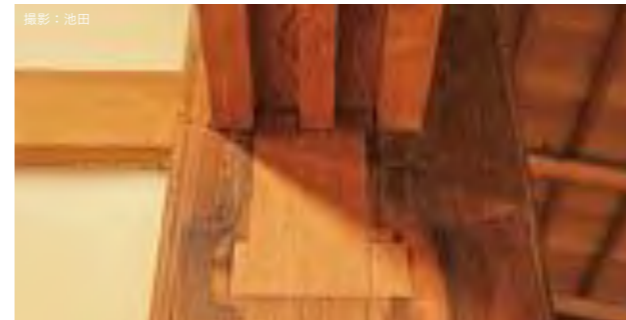
復原前から残る埋木処理の痕跡
