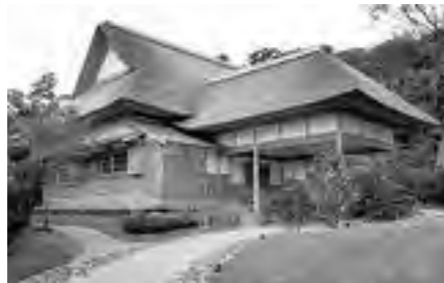
① 玄関（復原後）：元々の茅葺に戻され、規模も元に戻された
