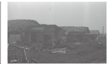
武蔵野町の破壊された民家 (写真提供：東京大空襲・戦災資料センター 撮影：石川光陽)
