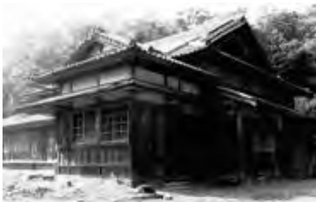
① 玄関（復原前）：瓦葺きの屋根で、規模が縮小されている
