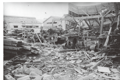
中島飛行機武蔵野製鋼第3工場の爆撃被害 (写真提供：東京大空襲・戦災資料センター)
