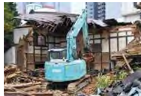
文化財に登録された蔵が解体される様子(筆者撮影)
