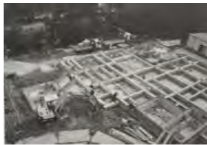
全解体後の基礎工事の様子 写真提供：マヌ都市建築研究所
