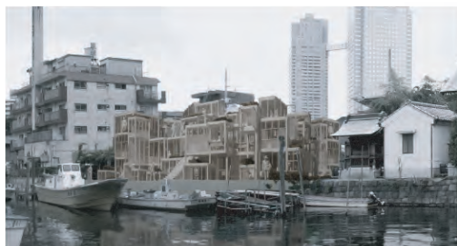
敷地 東京都中央区佃一丁目
